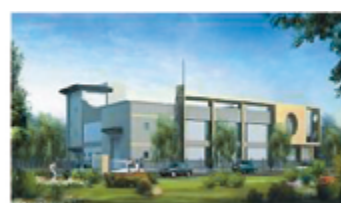
社口一次配電変電所外見図 着工日: 2005年7月7日 竣工日: 2007年12月23日
