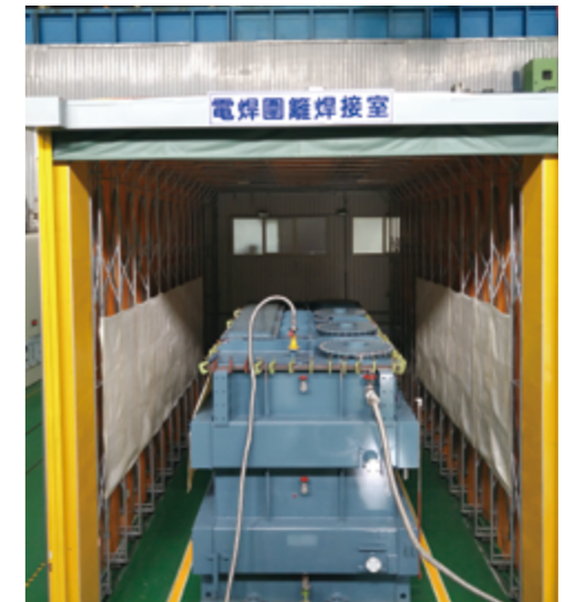
● 電焊圍籬焊接室
